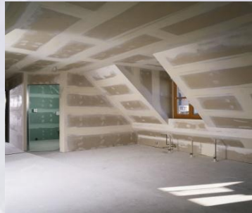
Anbau / Aufstockung / Dachgeschossausbau
